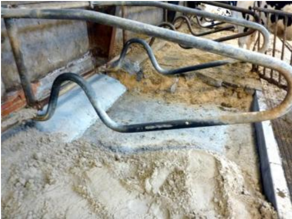
Figur 3. Den gamle sengebund fjernes, men fortovskanten, som udgør bagkanten, bevares. Der støbes en ny bund i sengene.
