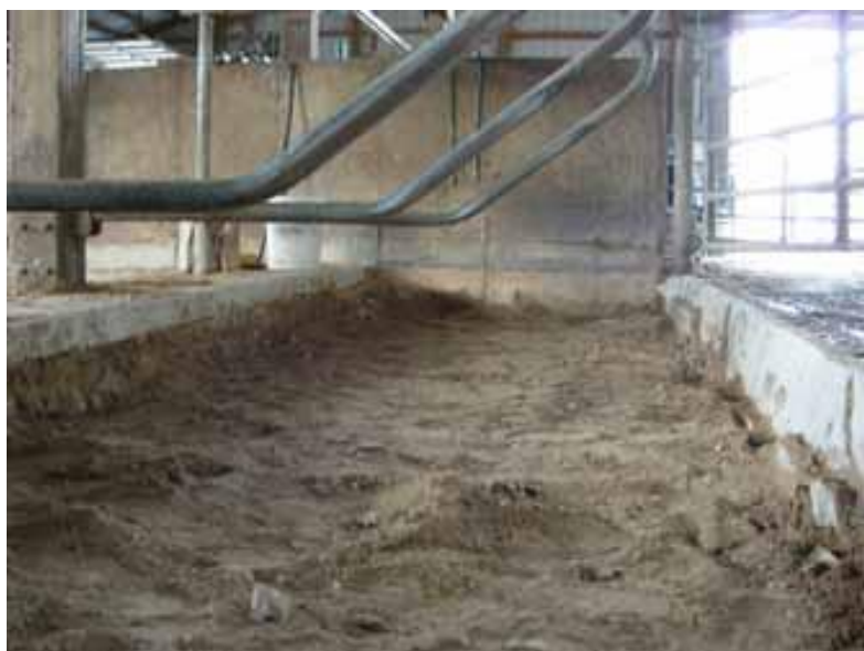
Figur 2. De eksisterende sengebåse er skåret væk, og der skal støbes en ny bagkant og ny bund. Kummen skal være mindst 25 cm dyb.
