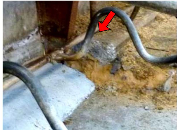
Figur 4. Den gamle beton "hovedpude" skal fjernes, fordi den er noget mere end 10 cm højere end bagkanten. Den lille nystøbte forhøjning har kun til formål at stabilisere inventarstolperne.
